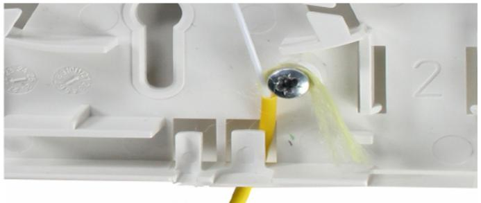
*Bild 9: Zugentlastung über Aramidfaser*
