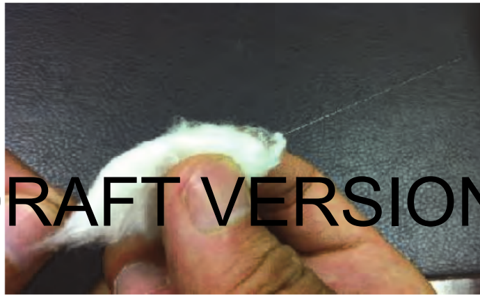
Abbildung 6: Reinigen der abgesetzten Faser
